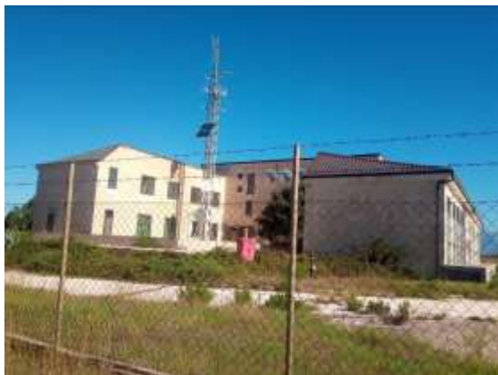
Postojeći manji antenski stup uz zgradu radio odašiljačkog središta
